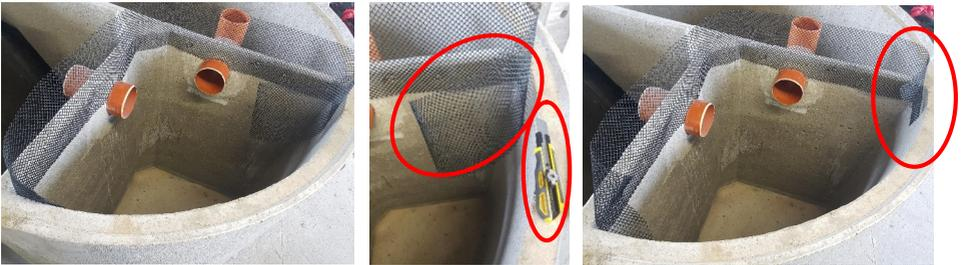
Nach dem Aufsetzen des Konus muss die Position des PE-Gewebes im Eckenbereich überprüft und ggf. zusätzlich am Konus fixiert werden.
