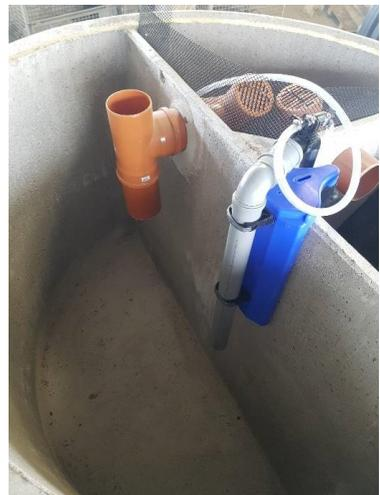
Um nur den Schlauch für die Schlammrückführung am Schlammheber anzuschließen, muss das werksseitig installierte T-Stück entfernt werden und der Schlauch direkt am Schlammheber angeschlossen werden.
