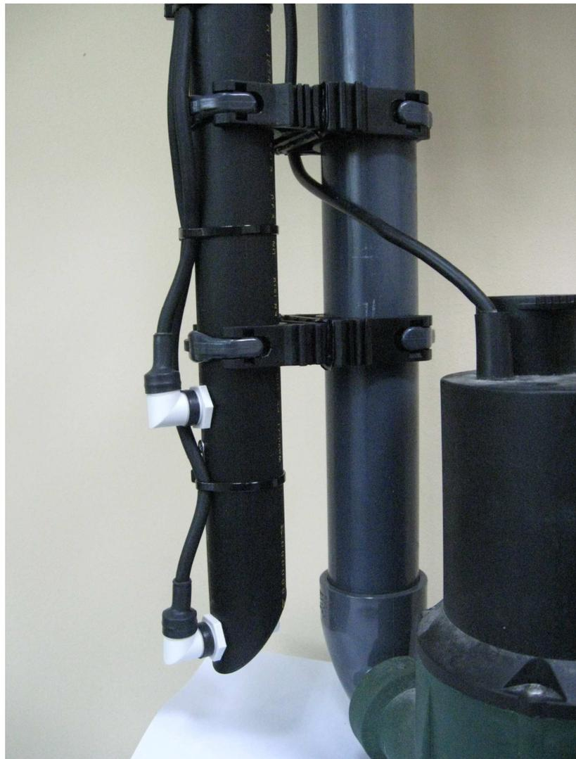
Abhängig von den Einbaubedingungen kann es sinnvoll sein, nach dem Winkel am Druckabgang der Pumpe eine Rückschlagklappe einzubauen. Ein vorzeitiges Aufschwimmen des aquaswitch durch den Rückfluß aus dem Steigrohr kann so vermieden werden.
