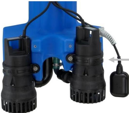
Der Ausschaltpunkt des Schwimmerschalters für den Klarwasserabzug befindet sich bei allen Typen auf Höhe der Pumpenhalteklammer (s. auch seitliche Markierung am PE-Rahmen).
