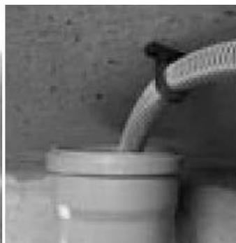
Das Ende des Klarwasserschlauches schieben Sie so weit in den Ablauf der Kläranlage, dass das Klarwasser nicht zurückfließen kann (ggf. Winkel am Ablauf vorsehen). Sichern Sie den Schlauch vor dem Herausrutschen mit einer Rohrschelle.
