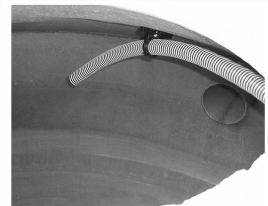
Schrauben Sie den vorbereiteten Schlauch für die Überschussschlammrückführung auf das Druckrohr der Überschussschlammpumpe.
