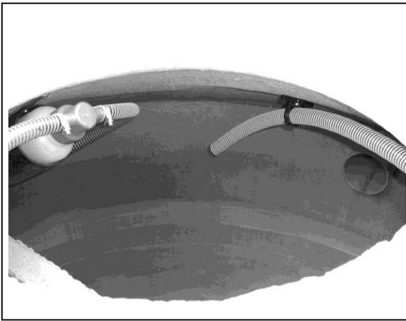
Ziehen Sie den Beschickungsschlauch durch das Verbindungsrohr in das SBR-Becken und befestigen Sie das Ende mit einem Kunststoffclip an der Abdeckung.
