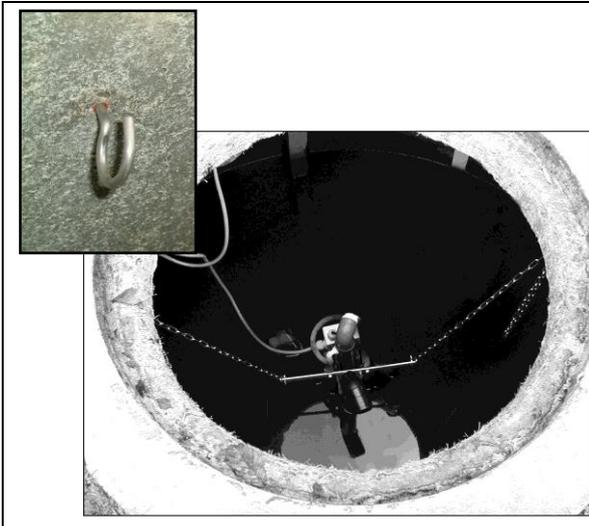
Die mitgelieferten Edelstahlhaken sind so an der Behälterdecke zu befestigen, dass der AQUAMAX® möglichst mittig im Behälter positioniert ist. Achten Sie darauf, dass die Leitungsabgänge für Schlamm und Klarwasser etwa in Richtung der entsprechenden Zu- und Ableitungen zeigen (die Abgänge sind bedingt drehbar).
